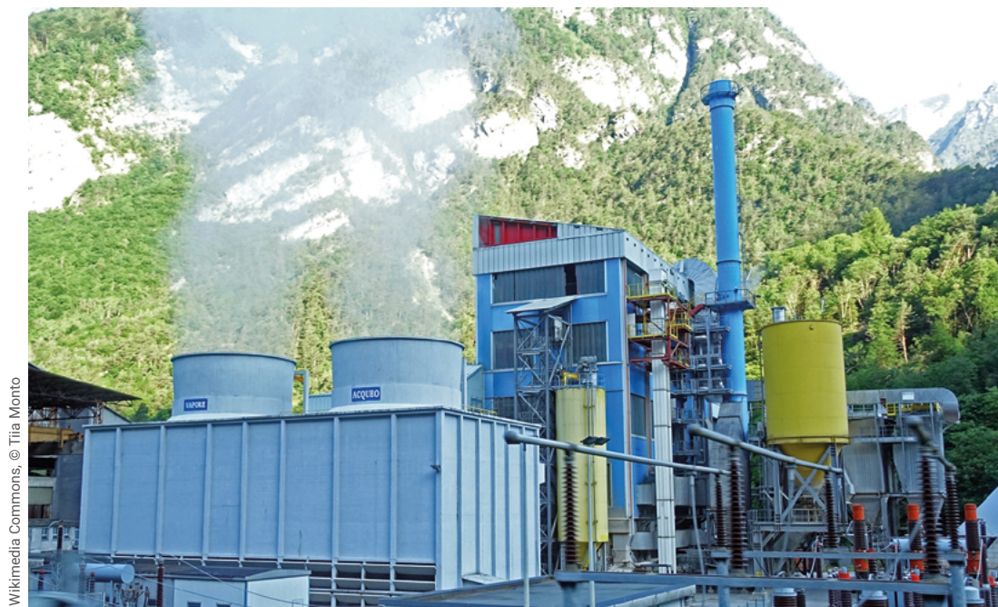
SICET, une centrale biomasse à Ospitale di Cadore, dans les montagnes de la Vénétie en Italie. Cette centrale produit de l'électricité grâce à la vapeur d'eau dégagée par la combustion de matières végétales, qui met en mouvement une turbine reliée à un alternateur.
